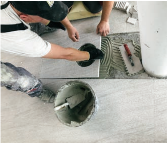
Marmor- und Granitböden werden meistens händisch verfugt. Foto: Haid-tec
